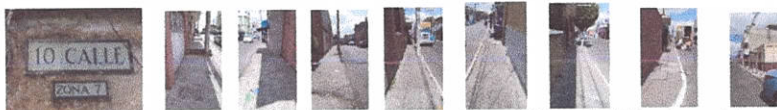
Banquetas de la 10ª. Calle de la 1ª. Avenida a la 7ª. Avenida de los dos lados se encuentran en mal estado las banquetas.
